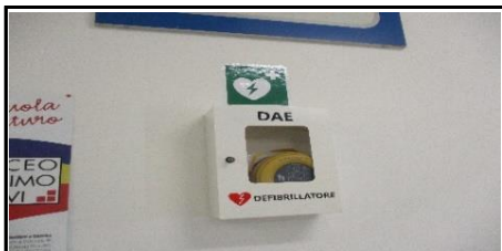
CORRIDOIO PIANO PRIMO IN PROSSIMITA' DEGLI UFFICI
