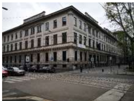
Il Complesso esterno
