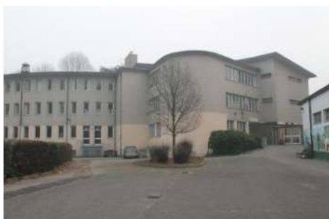
Il complesso esterno
