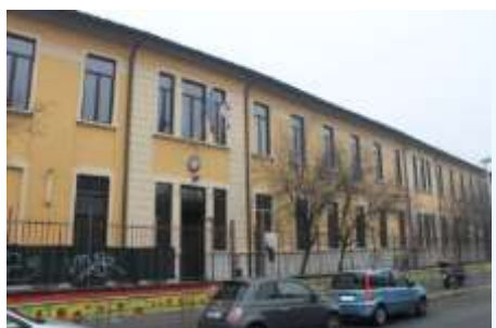
Il complesso esterno
