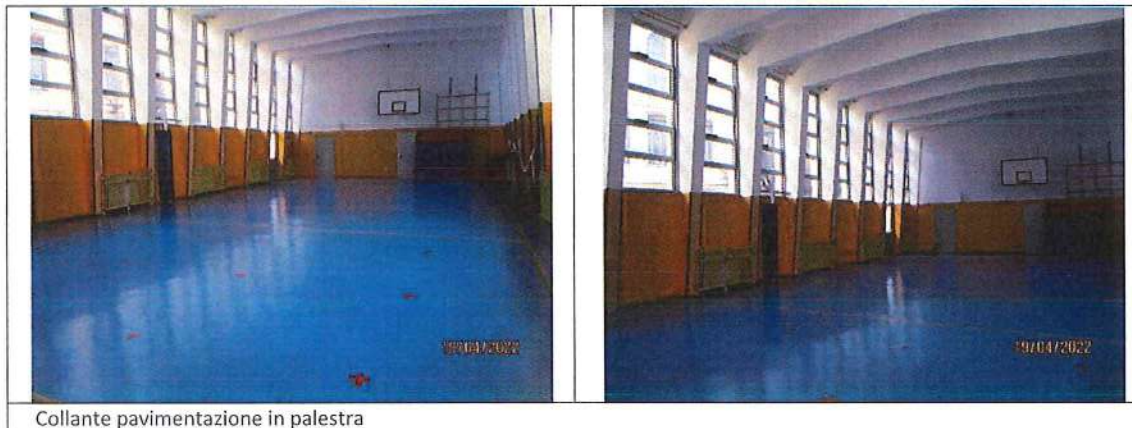
Collante pavimentazione in palestra
